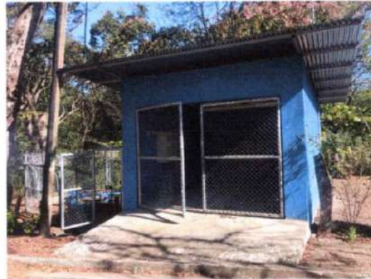
Figura 5. Caseta protección para equipos Pozo El Rastro.
