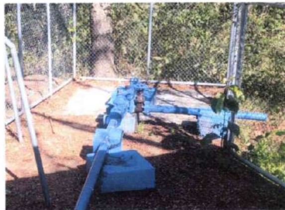
Figura 6. Pozo El Rastro y su cachera de bombeo.
