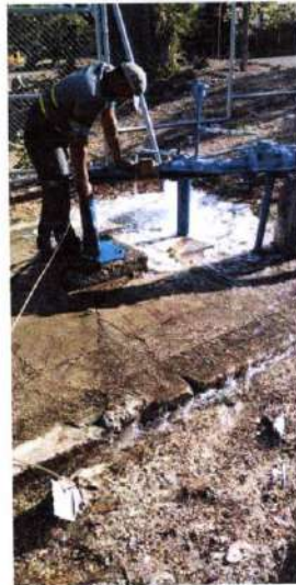
MEDICIÓN DE NIVELES DEL POZO
