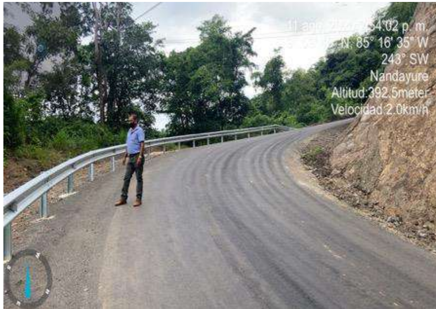
Obras de Drenaje- Base Granular- TSB-3
