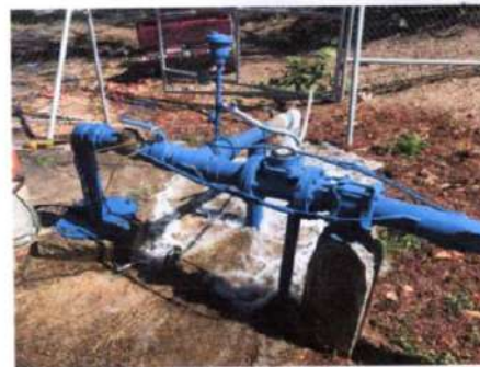
Figura 8. Pozo El Mango y su chaceara de bombeo.
