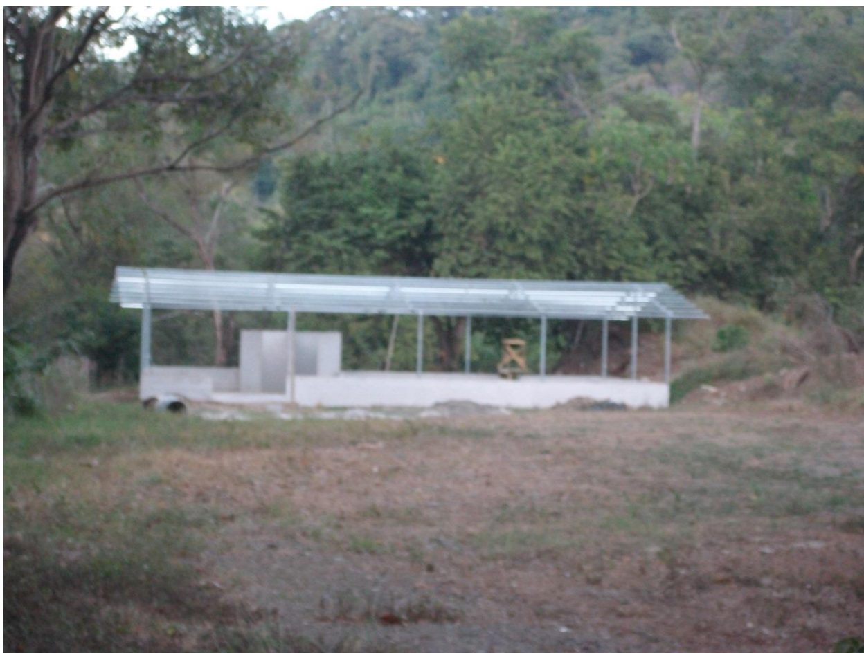
Figura 14. Construcción del centro de recuperación de residuos sólidos valorizables ordinarios localizado en el sector céntrico de Carmona.
